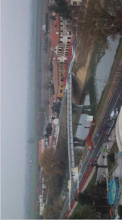
Il ponte ha una lunghezza complessiva, tra i fili interni dei parageai delle spalle, pari a 51,10 metri e si articola in tre campate con distanza tra gli apparecchi d'appoggio pari a 16,00 m, 18,30 m e 16,00 metri. La larghezza fuori tutto dell'impalcato è di 14,70 metri e risulta costituito da un marciapiedi lato monte largo 2,10 metri, da una carreggiata di 9,50 metri e da un marciapiedi lato valle largo 3,10 metri sul quale è stata prevista una pista ciclabile.
